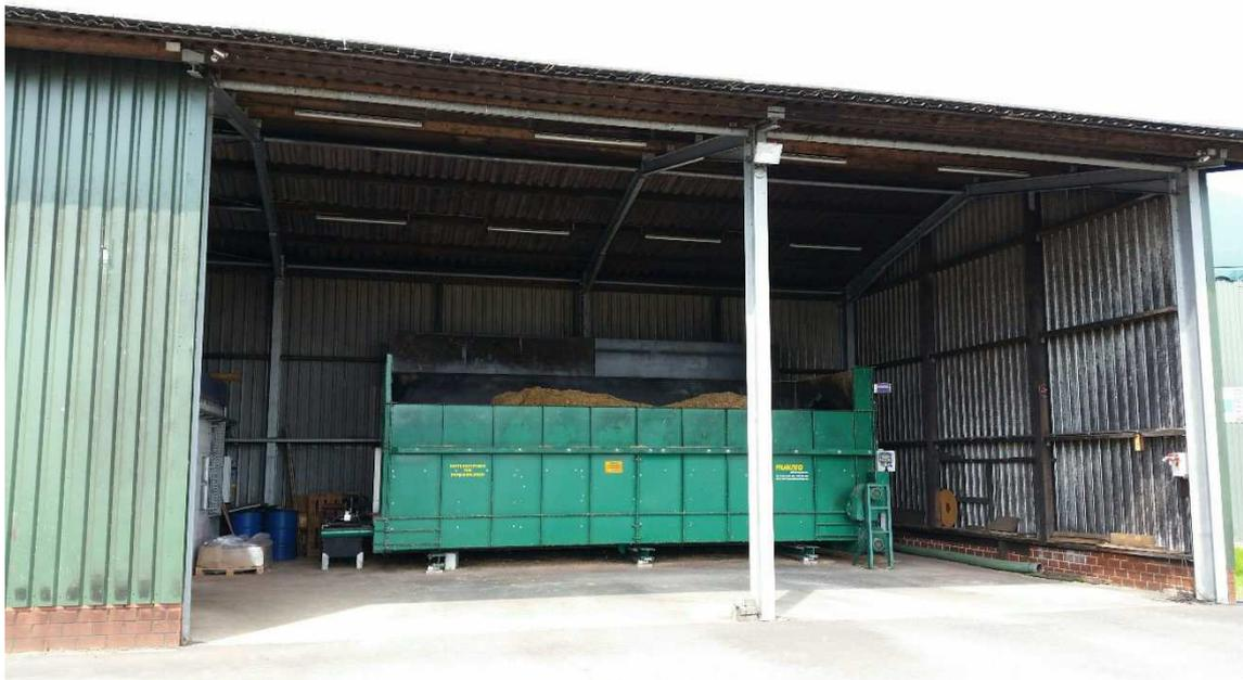
**Bild 2:** Blick von Süden in das dreiseitig umwandete Hallengebäude mit der dortigen Schubbodencontainer (= Feststoffvorlager)
