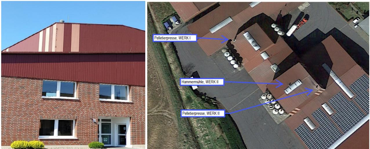
**Bild 5:** Abluftkamin der Pelletierpresse von Werk II (links), der dahinter liegende in etwa gleich hohe Kamin der Hammermühle ist von der Bodenposition aus nicht einsehbar, aber im Luftbild erkennbar (Bild rechts)
