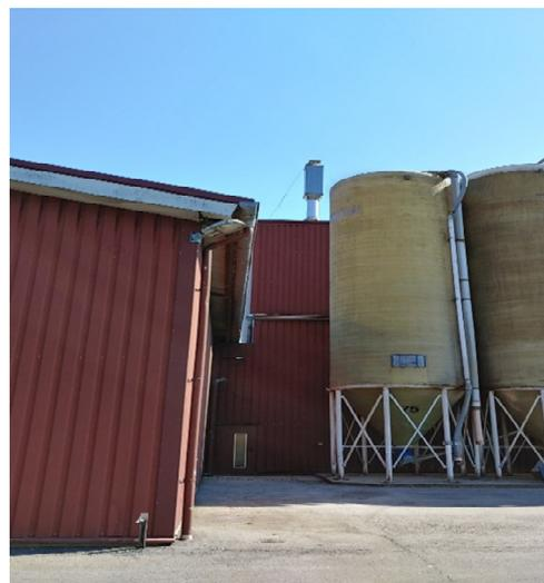
**Bild 4:** Emissionsquellen der Hammermühle (links) und der Presse (rechts) von Werk I
