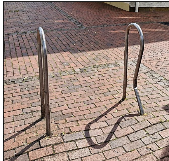
Abbildung 23: Beispiele beschädigter Fahrradbügel (Eigene Aufnahmen)
