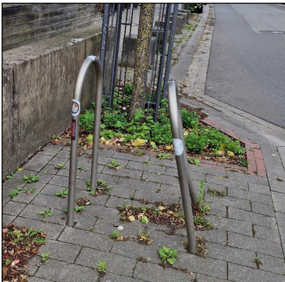
Abbildung 23: Beispiele beschädigter Fahrradbügel (Eigene Aufnahmen)
